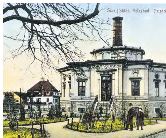
▲ Das Volksbad („Tröpferbad“), nun größtenteils das Museum für Wahrnehmungen (MUWA) in der Friedrichstraße um 1910. Der zentrale Kamin war Teil der alten Heizungsanlage (Friedrichgasse 41).
