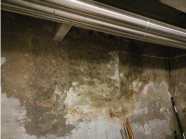
**Abbildung: Lager Untergeschoss, massive Feuchteschäden**
