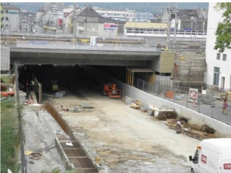
Brückentragwerk Eggenberger Straße, entfernen des Füllmaterials
