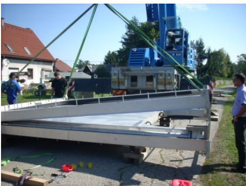
Absperrschütz, Vorbereitungen zum Transport und Einbau
