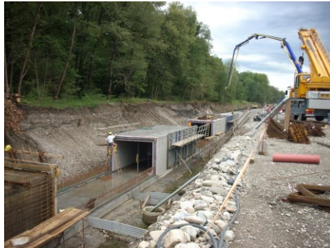
Ortbetonabschnitte HSEK
