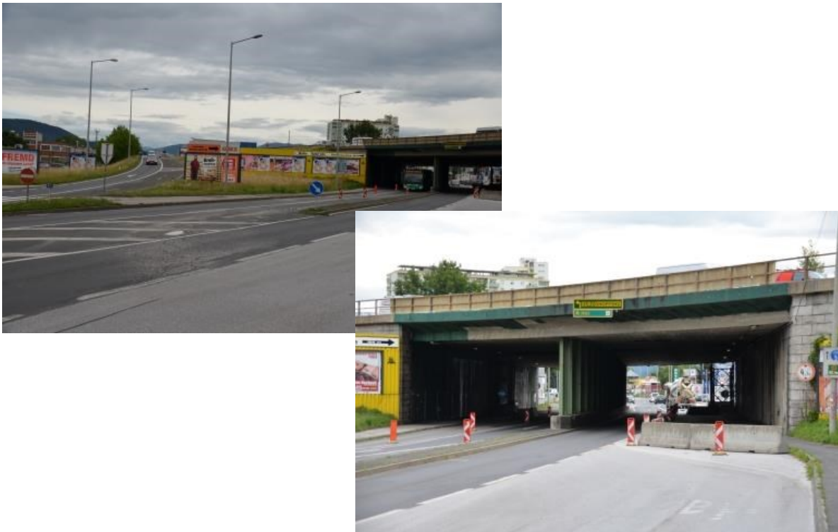
Abbildung: Abfahrtsrampe und Brückentragwerke, Blickrichtung stadteinwärts Quelle: StRH
