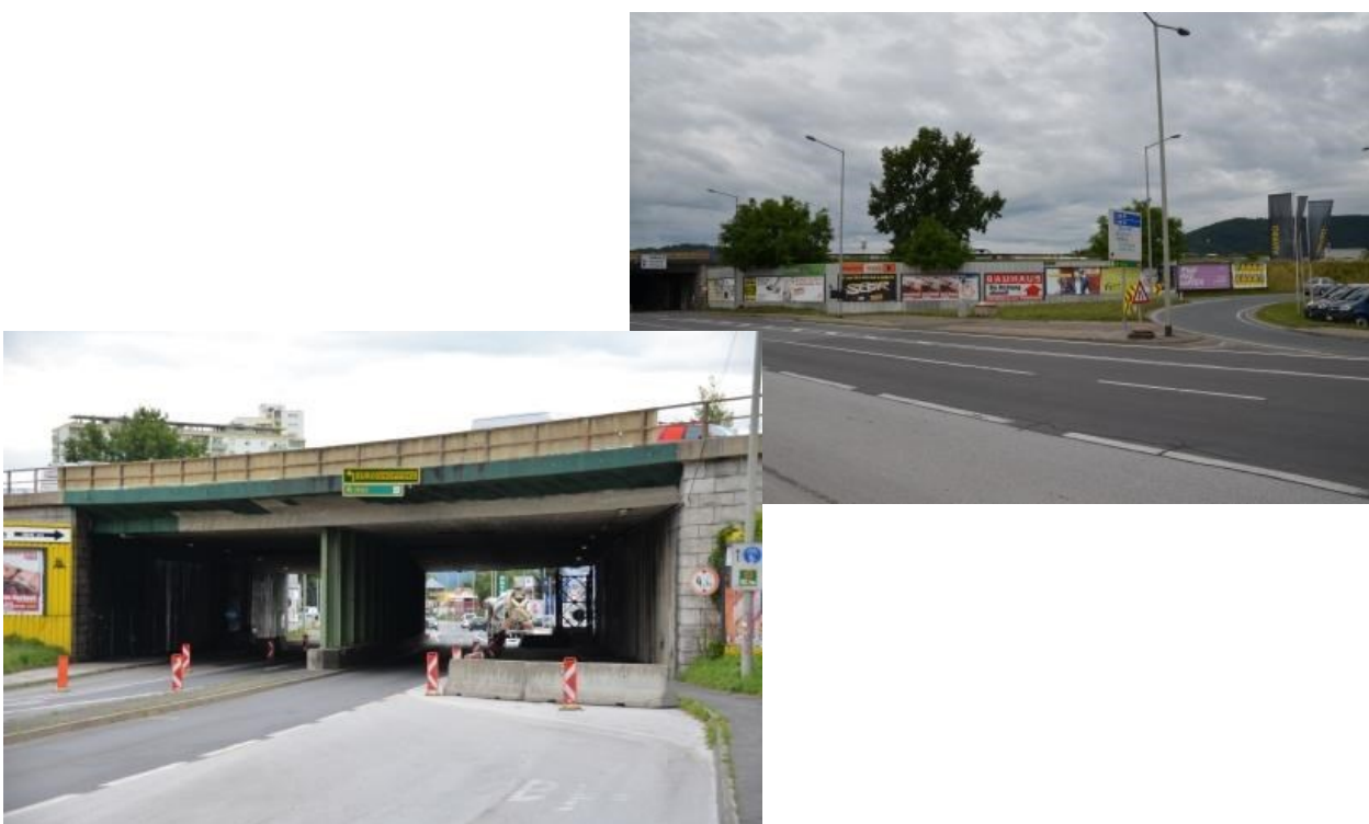
Abbildung: Brückentragwerke und Auffahrtsrampe, Blickrichtung stadtauswärts Quelle: StRH
