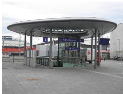
Abgang Wagner-Biro-Straße Straße
