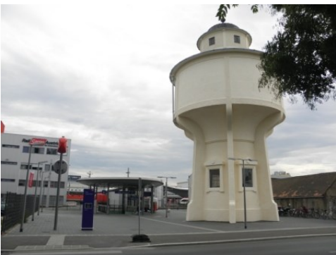
Vorplatz und Abgang Wagner-Biro- Straße
