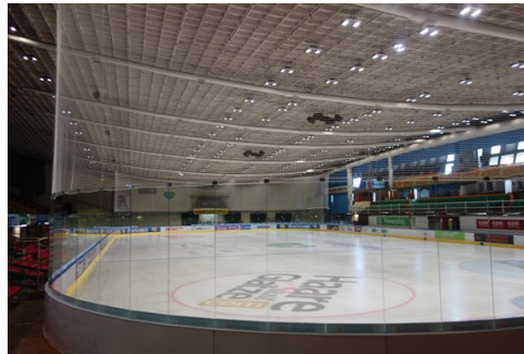
Eistechnik baulich abgeschlossen
