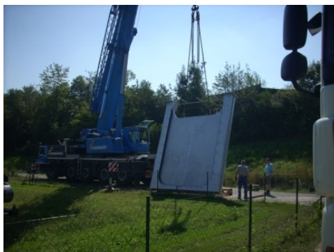
Absperrschütz, Vorbereitungen zum Transport und Einbau
