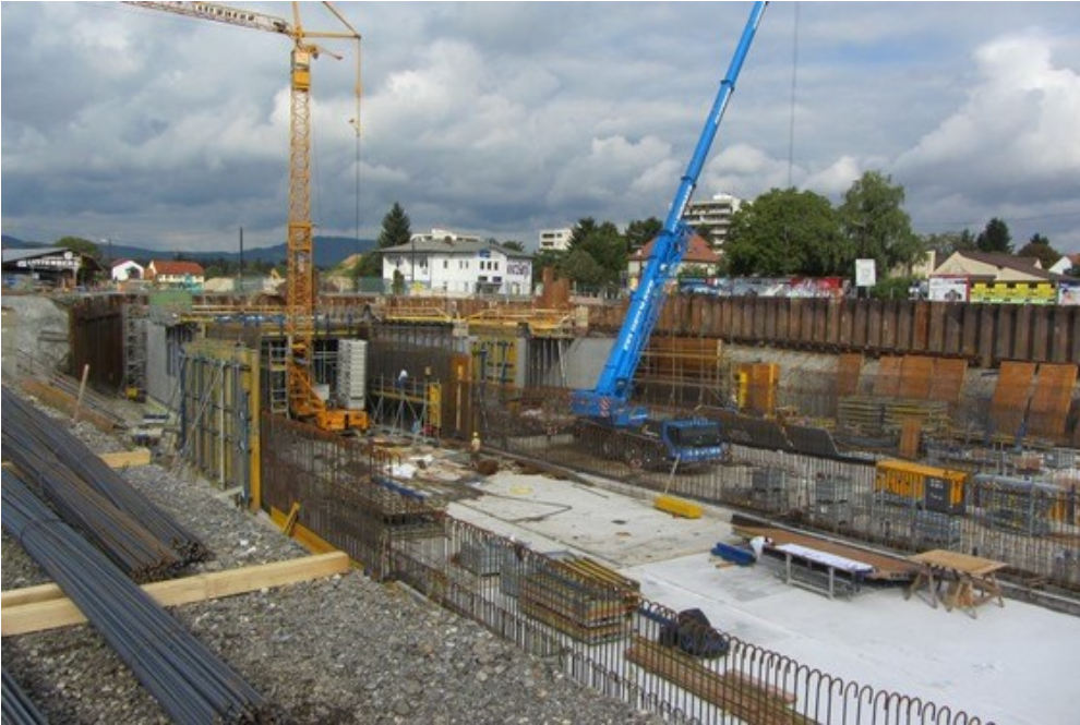
Baustelle Südgürtel; Foto StRH
