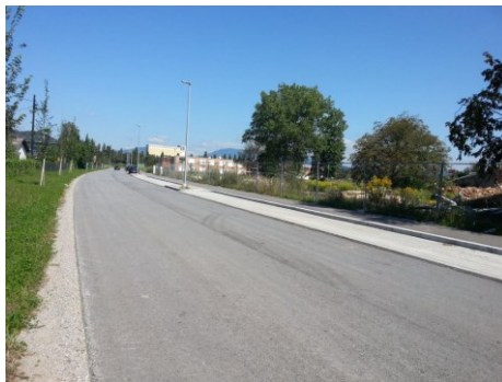
Fahrbahn bzw. Gehweg und Grün-Grünstreifen Nord-Süd
