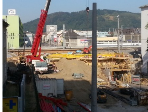
Neubau Brückentragwerk Eggenberger Straße
