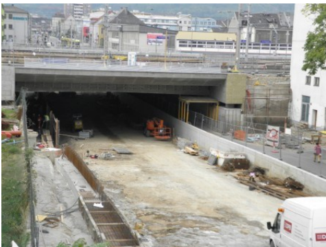
Brückentragwerk Eggenberger Straße, entfernen des Füllmaterials
