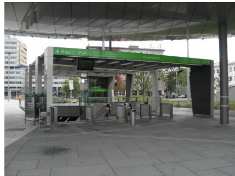
Abgang STRAB-Haltestelle stadteinwärts
