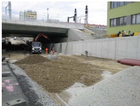
Brückentragwerk Eggenberger Straße mit erhöhtem Rad- und Fußweg
