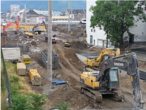
Abbruch Brückentragwerk Eggenberger Straße
