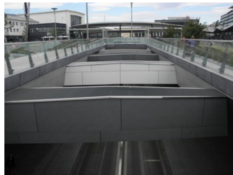
Haltestellenbereich von oben
