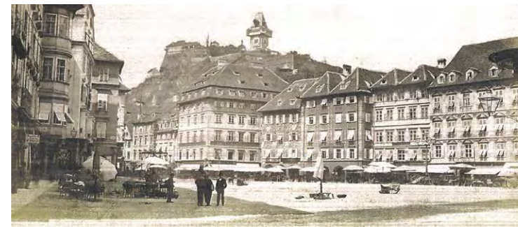
1875 gibt es noch kein Denkmal, links seitlich (Sackstraße) wird die Dreifaltigkeitssäule demontiert.
