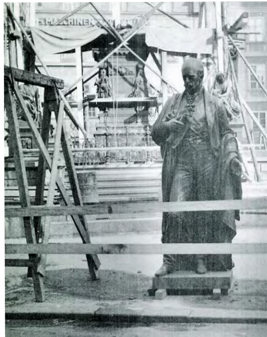
1976 und 2009 zur Renovierung demontiert.
