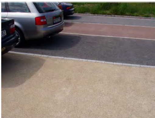
BODENBELAG WASSERGEBUNDENE DECKE
