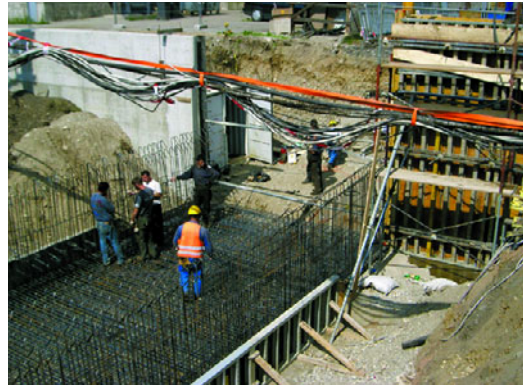
Zügige Baufortschritte an der Unterführung der Mitterstraße – bis Sommer 2005 sollen die Arbeiten fertig sein.
