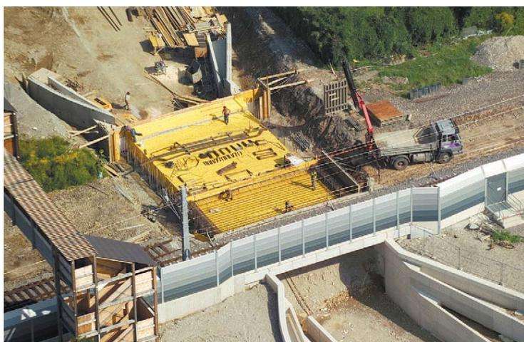
Schalungsarbeiten bei den Bahnbrücken für die Gleise in der Feldgasse.
